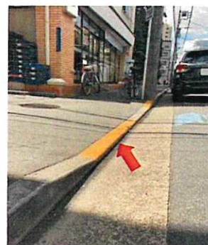
車道と歩道の段差5cmの例（矢印） ※ 前方に停車中の自動車为了避免のために、歩道との段差5cmを乗り越えて走行する場合がある。
